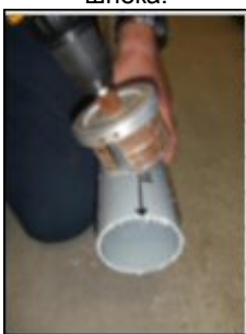
4. Наклоните сверло к себе и рассверлите отверстие.
